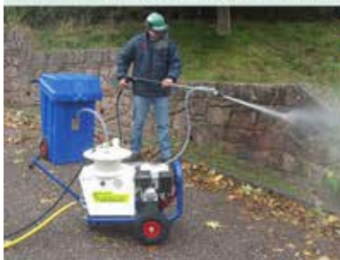
Limpieza chorro arena
